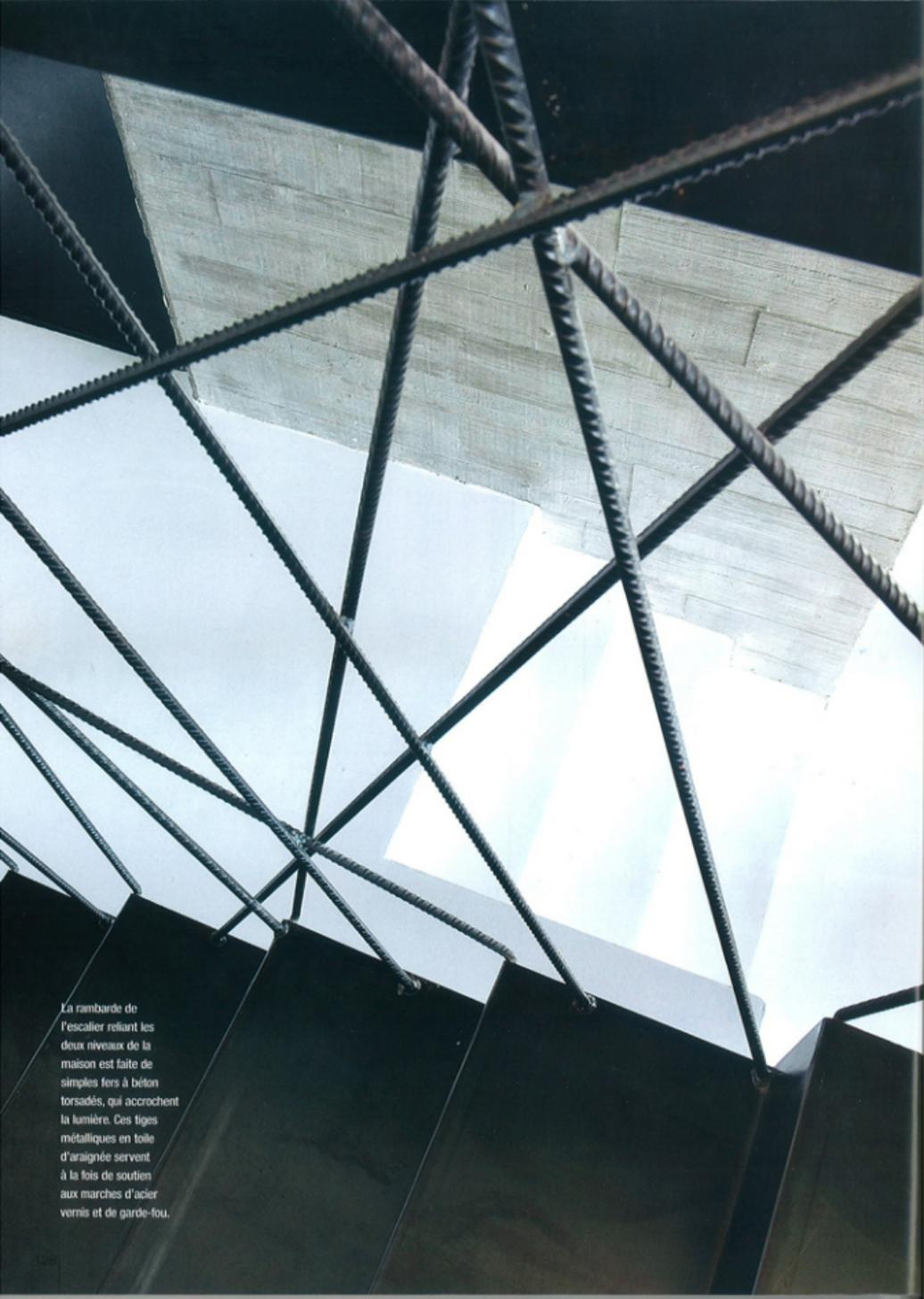
La rambarde de l'escalier reliant les deux niveaux de la maison est faite de simples fers à béton torsadés, qui accrochent la lumière. Ces tiges métalliques en toile d'araignée servent à la fois de soutien aux marches d'acier vernis et de garde-fou.
